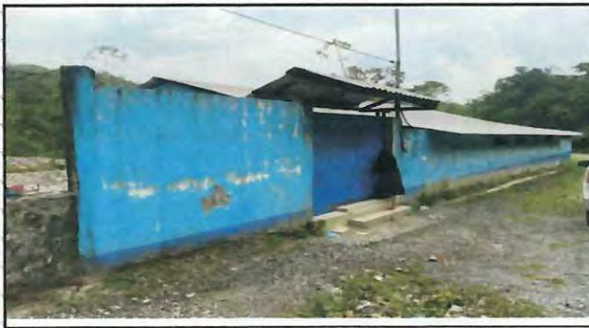
Foto 4: PINTURAS EN MURO DE INTERIORES Y EXTERIORES
