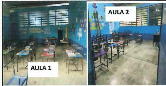
Foto 5: SUSTITUCION DE PISO CERAMICO EN AULAS
