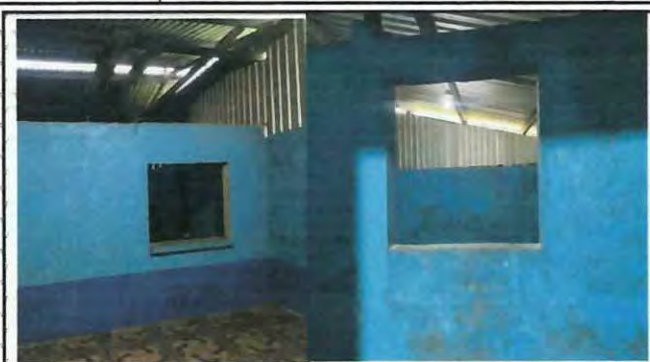
Foto 2: COLOCACION DE 2 VENTANAS
