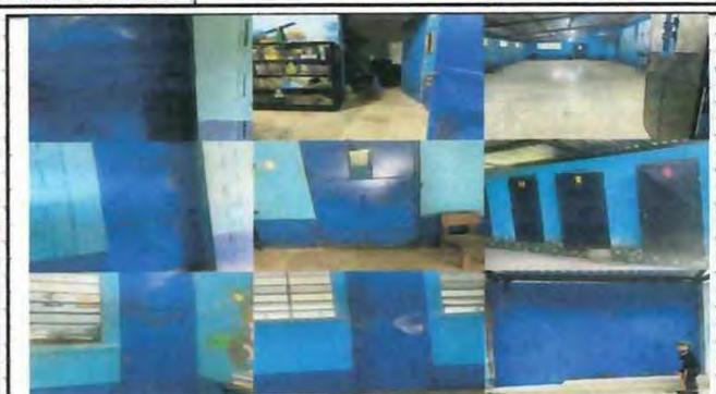
Foto 1: MANTENIMIENTO LIJADO APLICACIÓN DE PINTURA 13 PUERTAS
