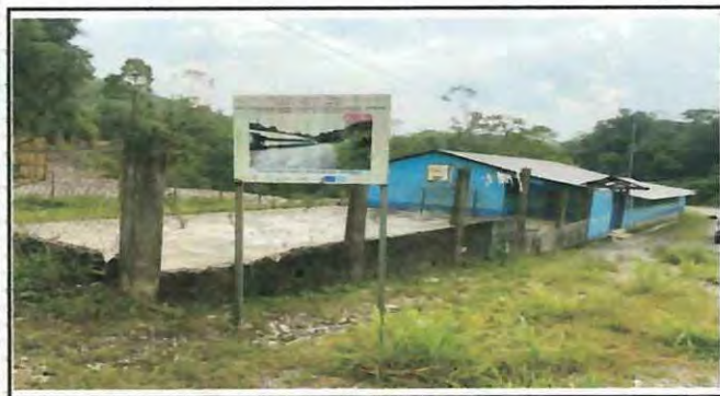
Foto 3: REPACION DE MURO PERIMETRAL DE BLOCK
